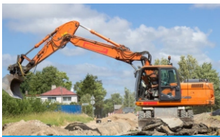
工程挖掘机充电
